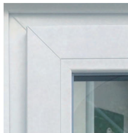
intect -Beschlag mit verdeckt liegendem Beschlag.
